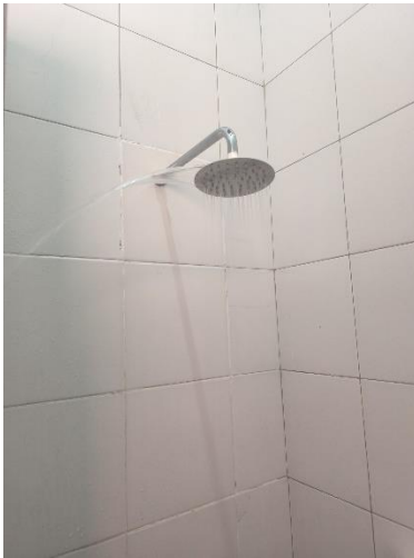
Registro de fuga en ducha-alojamiento Registro fuga orinal
