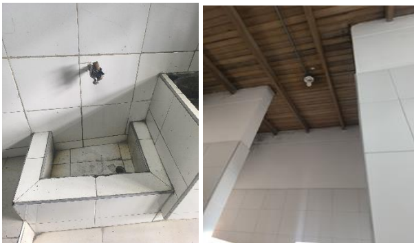
Registro de falta de llave cerca al lavadero - Registro humedad zona de baños
