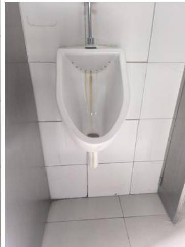
Registro de fuga en ducha-alojamiento Registro fuga orinal
