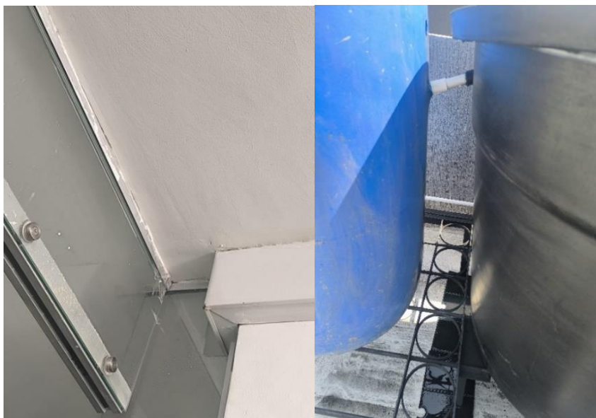
Registro de perfiles mal pintados -Registro fotográfico-fuga de agua
