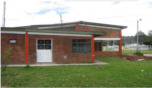
Figura 13, Antigua Estación de San José de Bavaria.
